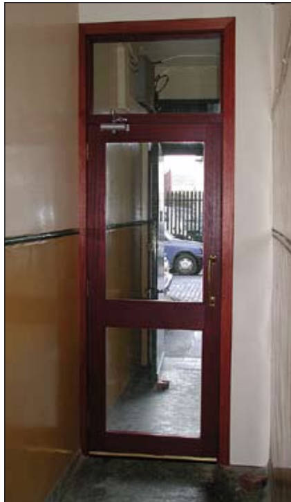
Draught lobby door to a tenement
